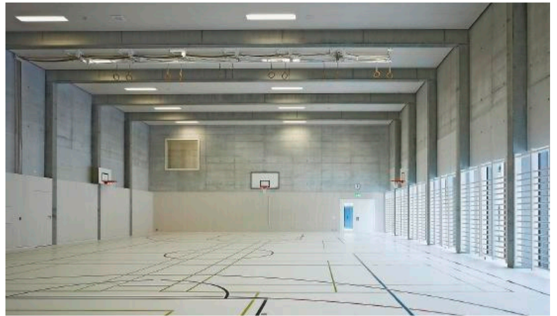
Sporthallen Gymnasium Liestal BL, von Sabarchitekten Fotos: Ruedi Walti
